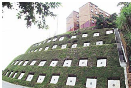
Talud con anclajes
